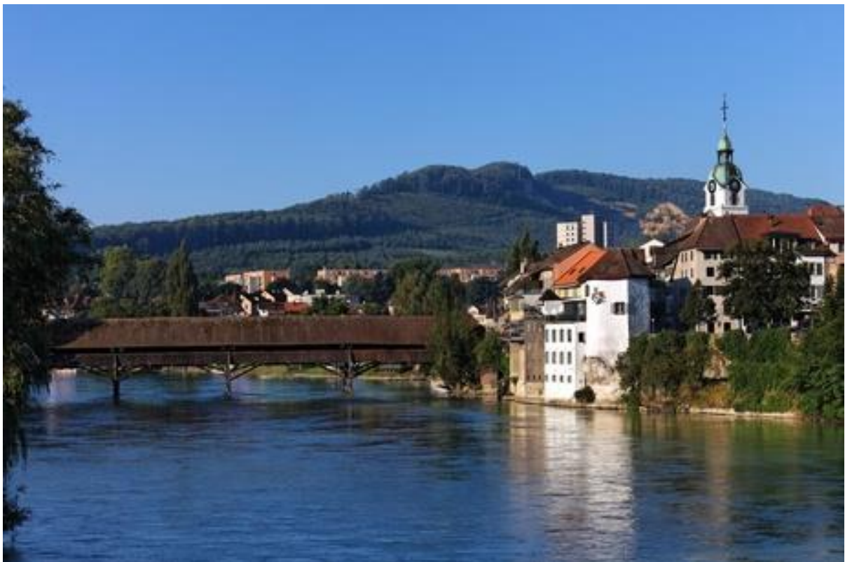
Olten mit Holzbrücke zur Altstadt
